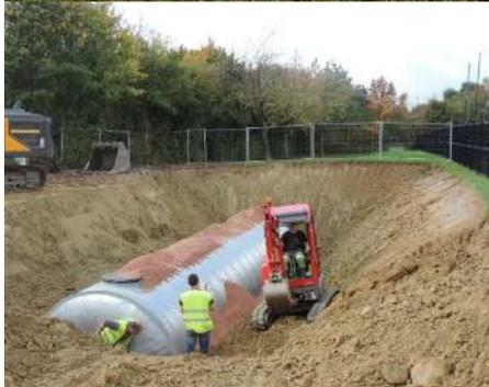
Alimentation d'une cuve de 101 m<sup>3</sup> à proximité du terrain
